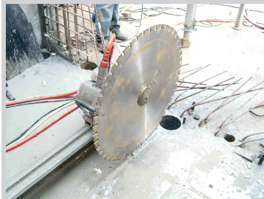
Cięcie piły ścienną
